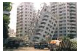
Ил. 40.15. Наслідки землетрусу
