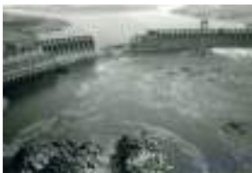
Іл. 40.8. Зруйнована вибухом гребля Дніпрогесу в 1941 р.
